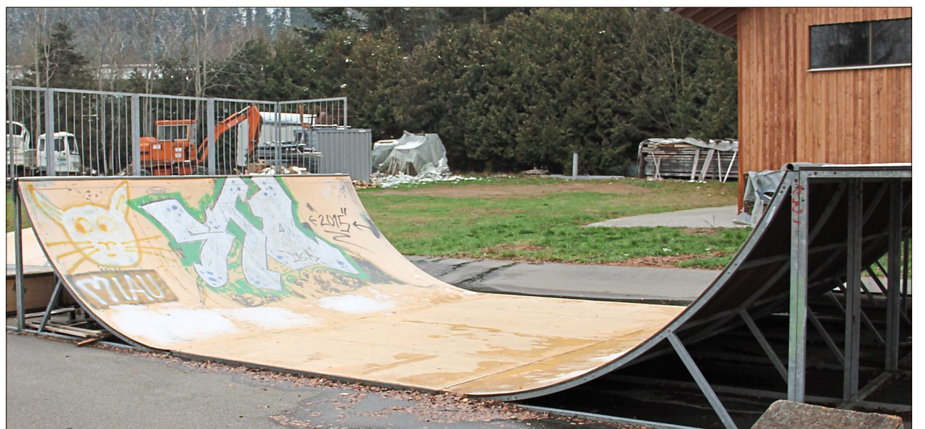
Der Skatepark im Gewerbegebiet ist in die Jahre gekommen und sanierungsbedürftig. In der nichtöffentlichen Sitzung des Stadtrates beschloss man, die Geräte instandzusetzen – und beim Haus der Begegnung neu aufzubauen. Foto: Zitzelsberger
