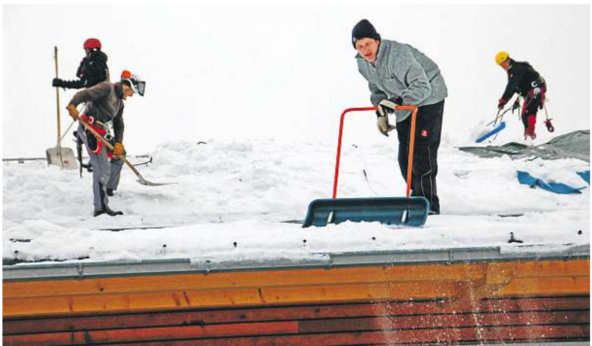
Angeleint und gesichert schaufeln die Arbeiter der Firma Hartl das Kuppeldach der Hammerseehalle frei. Foto: K. Beer
