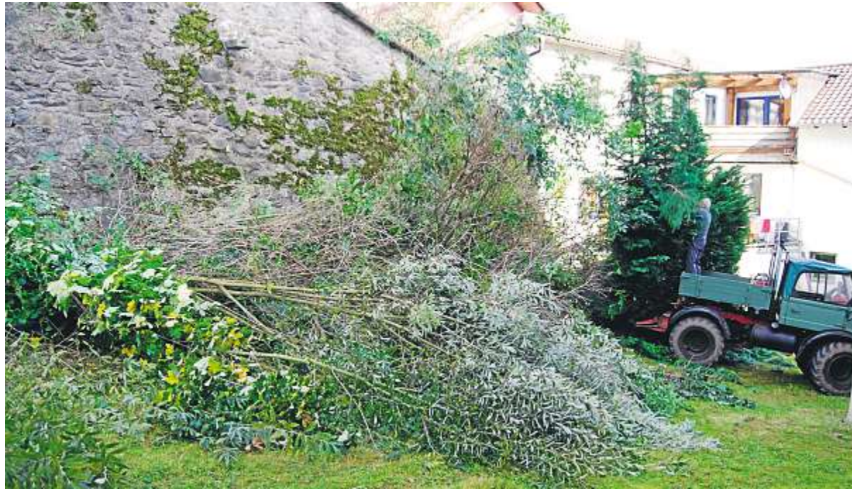
Im Burggraben neben dem Zugang zur Kirchenburg sind seit Jahrzehnten Bäume und Stauden unkontrolliert gewachsen. Stadtpfarrer Herbert Mader packte selbst mit an, als Franz Hackl, Franz Stauber und Josef Kollmer mit dem Zuschneiden und teilweisen Entfernen des Wildwuchses begannen, der die Mauern beschädigt. Fotos: Dachs
