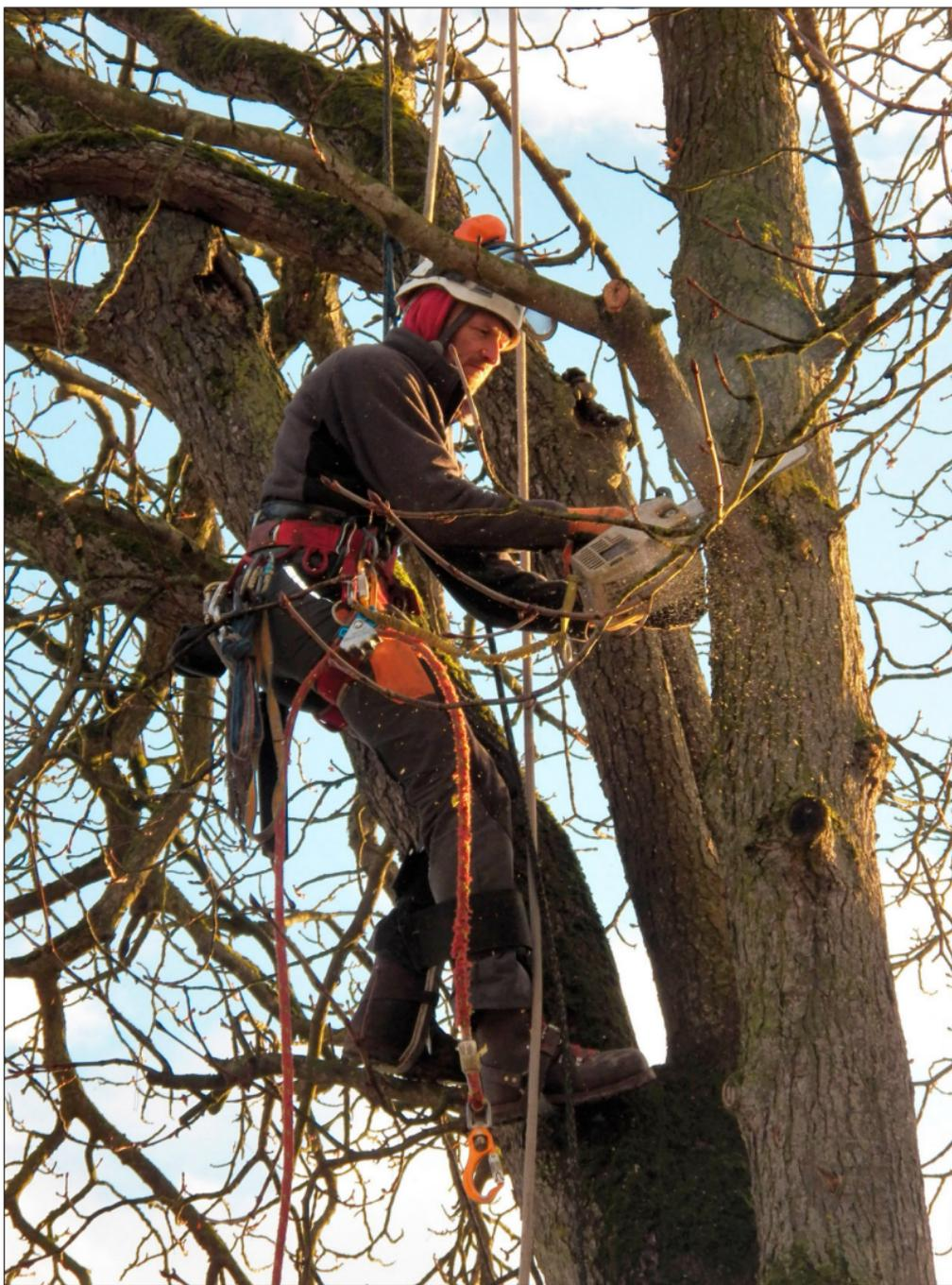
**Angehängt** an spezielle Kletter- und Lastseile haben die Facharbeiter zunächst die Baumkronen der Kastanien ausgeastet. – Foto: Schiller
